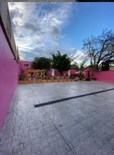
SOBRE CONCRETO ESTAMPADO
