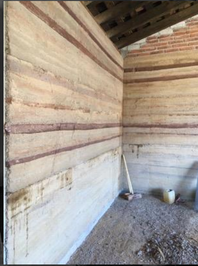
SOBRE MURO DE TIERRA COMPACTADA
