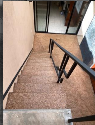
SOBRE CONCRETO MARTELINADO/LAVADO
