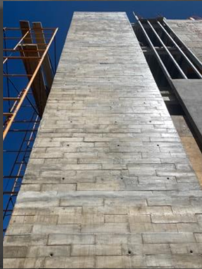
SOBRE CONCRETO ENDUELADO APARENTE
